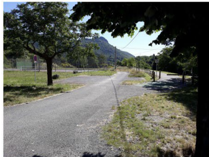
Vue générale du parking
